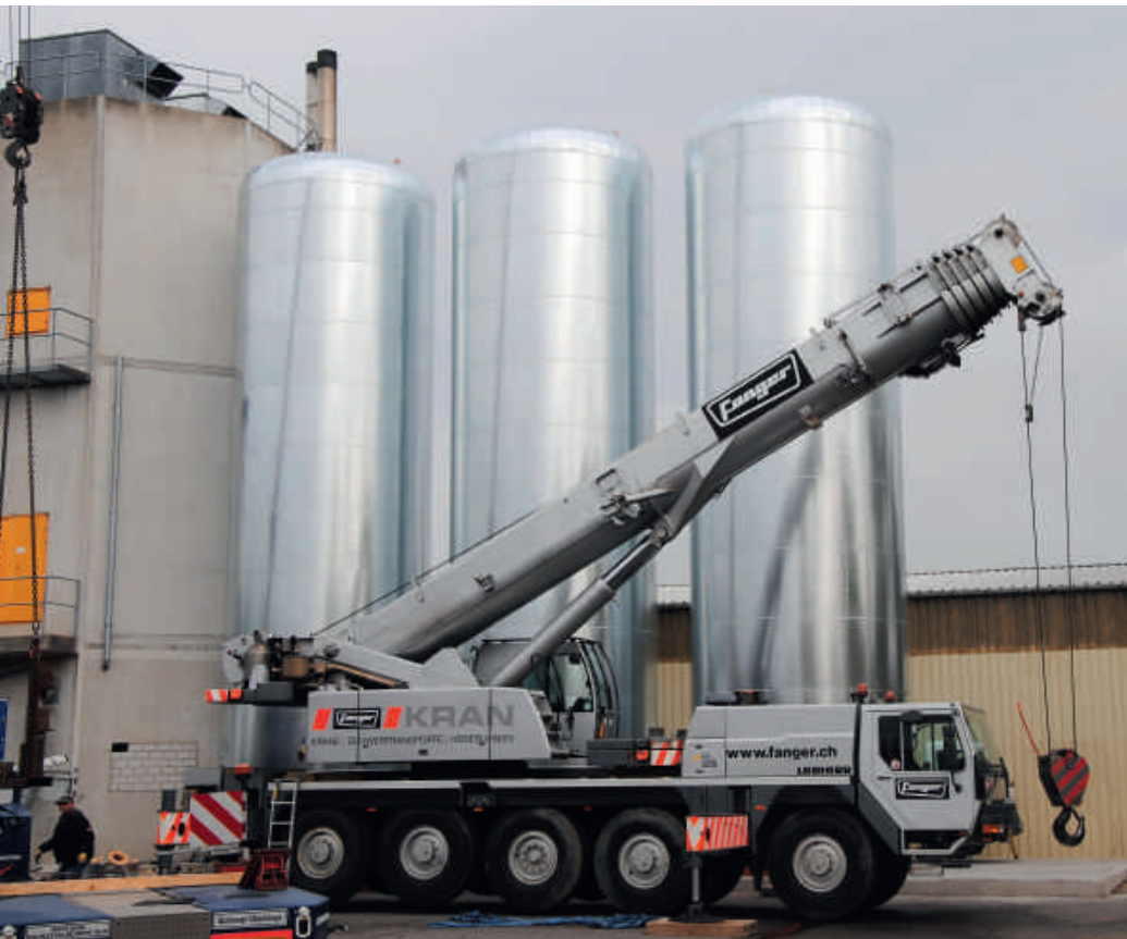
3 Wärmespeicher à 125 m 3 mit werkseitig montierter Isolation aus Mineralwolle 200 mm mit Alu-Mantel werden montagefertig auf die Baustelle angeliefert.
