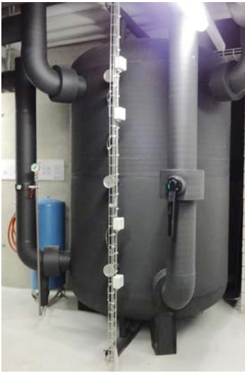
Platzisolierung für Kältespeicher.
