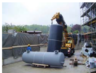
Wärme- und Kältespeicher für ein Gewerbeobjekt.
