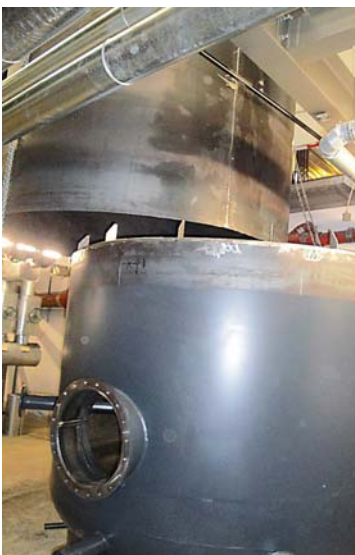
Platzschweißung Wärmespeicher.
